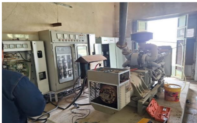
راه اندازی ژنراتور برق اضطراری چاه‌ها و سامانه پمپاژ آبیاری ایستگاه تحقیقاتی اکباتان
