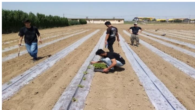
پروژه آبیاری قطره‌ای و پوشش مالچ پلاستیکی
